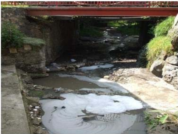
Foto 19. Presencia de agua jabonosa en el lugar
