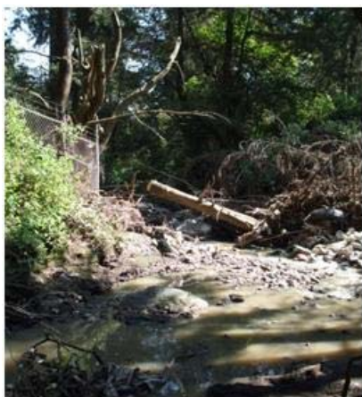
Foto 31. Derribo de árboles
