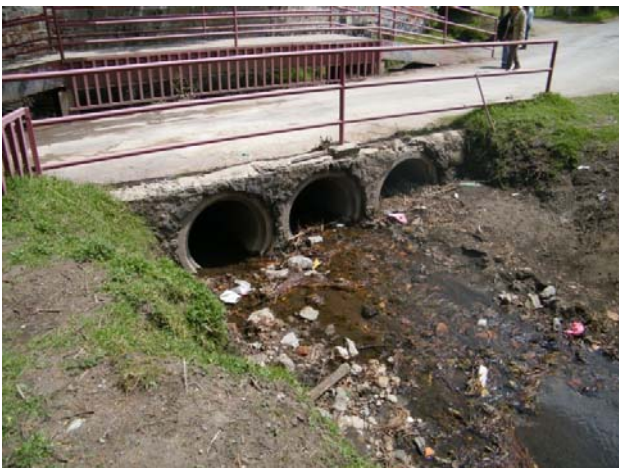
Vistas de la infraestructura existente a lo largo de la barranca "San Buenaventura".
