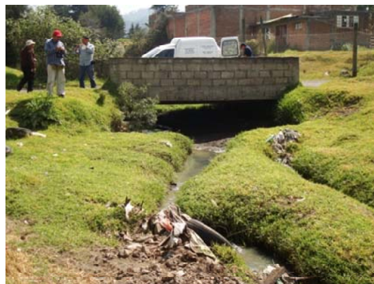
Azolvamiento del cauce de la barranca, el cual está cubierto por “zacate kikuyo”
