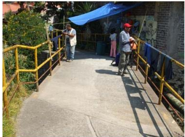
Foto 40. Intersección de barranca con calle
