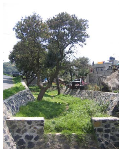
Tramo de la barranca en el que se ha construido un canal.
