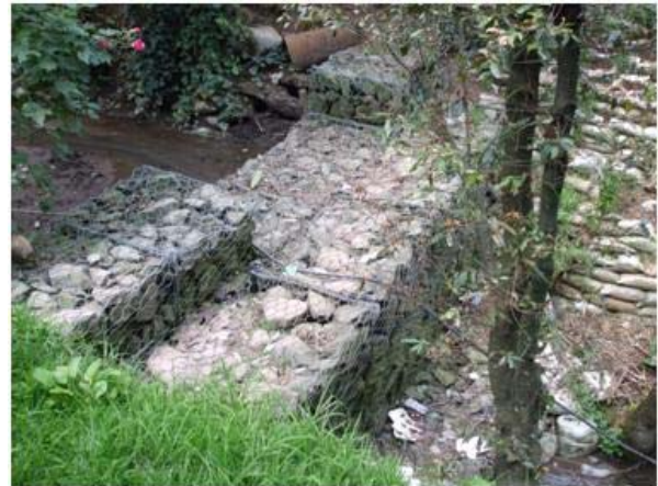
Foto 75. Presa de gaviones
