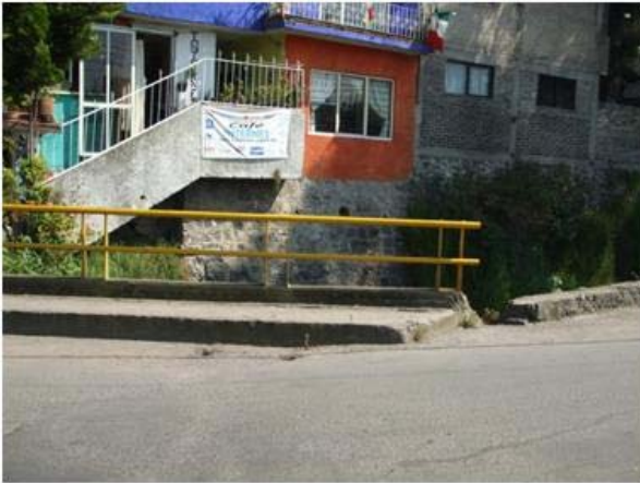
Foto 41 .Descarga de agua de lluvias de la casa
