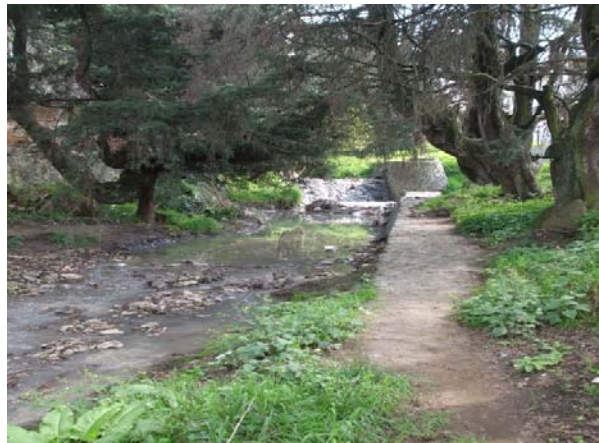
Foto 20. Sistema de alcantarillado de la red de drenaje
